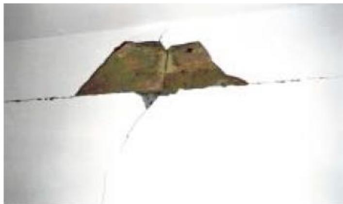
2、水平向裂縫多且延伸至柱，裂縫寬度 0.3~0.5mm。
