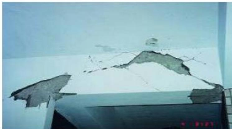
4、保護層脫落範圍度大，部分箍筋脫開或斷裂，主筋可能挫屈。
