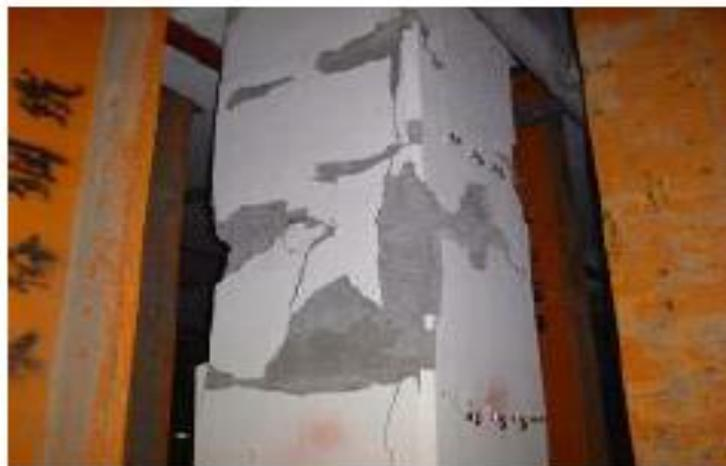
保護層脫落範圍度大，部分箍筋脫開或斷裂，主筋可能挫屈。
